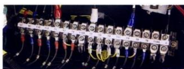
短絡プレート(200V⇄400V切替)
